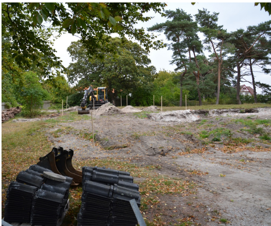
Figur 3. Undersökningsområdet innan schaktning. I högra bildkanten syns hålet efter det rivna husets källare.
