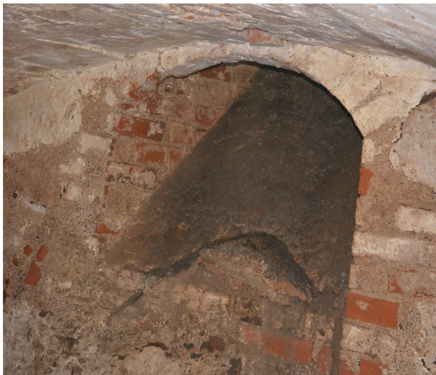
Figur 6. Foto över ljusschaktet i kryptans norra gavel.
