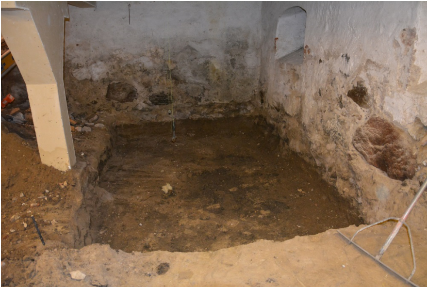
Figur 6. Schaktet efter handschaktningen.
