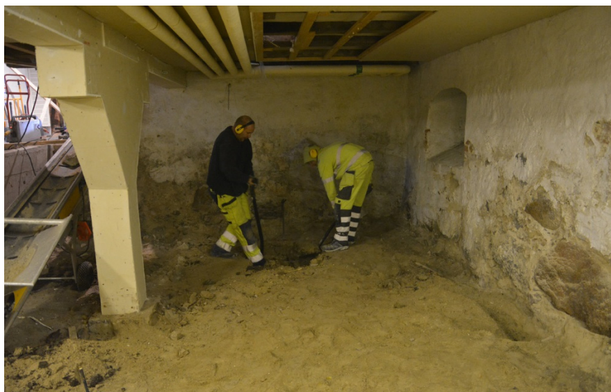
Figur 4. Schaktet för hissen grävdes för hand.
