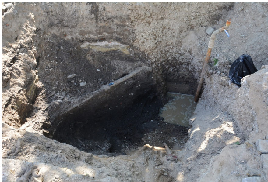
Figur 7. Fotot visar schaktet med gjutjärnsledningen som går snett över bilden. Till höger ses den läckande ledningen
