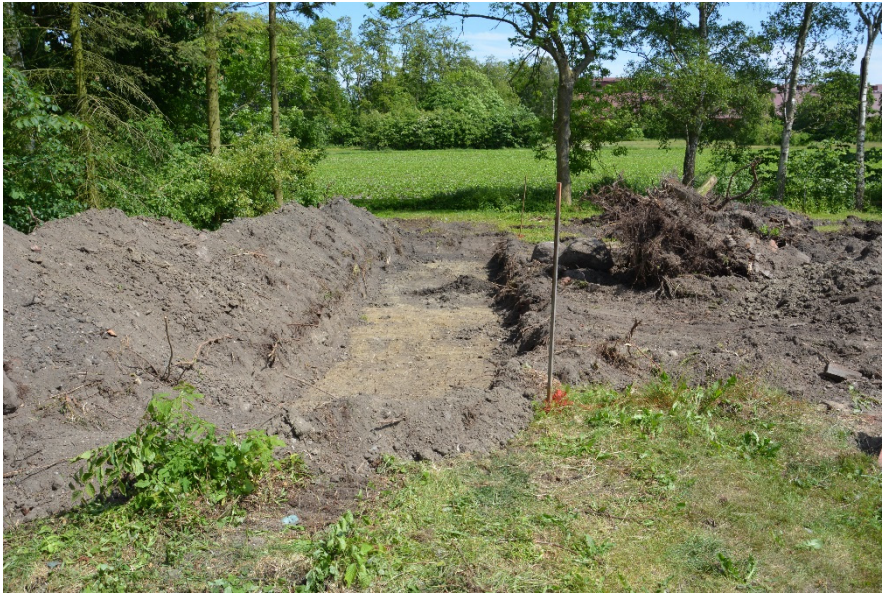
Figur 5. Bilden visar det nordliga schaktet. Fotot är taget från väster.
