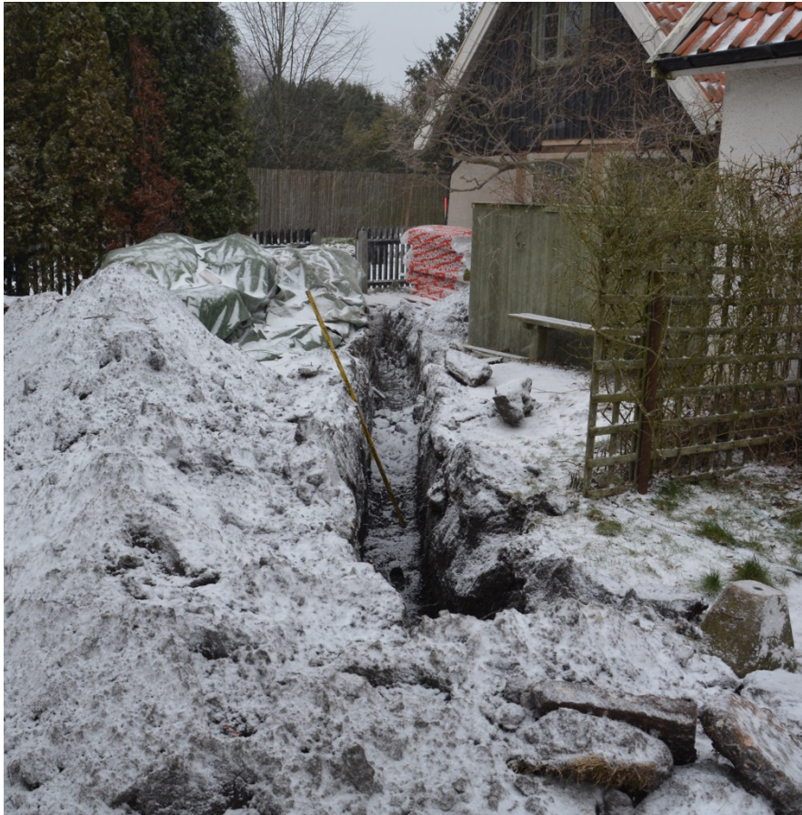
Figur 5. VA-schaktet inne på tomten. Fotot är tagen från sydost mot Sjövägen
