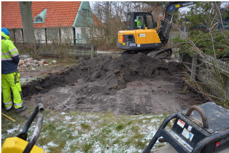
Figur 6. Schaktningen för bilupställningsplatsen. Fotot är taget från norr
