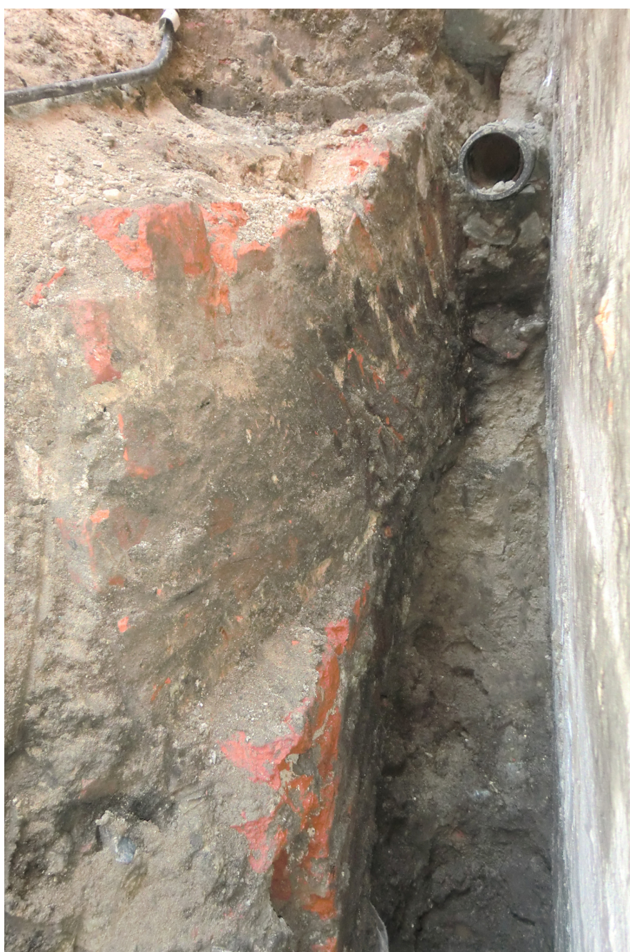
Figur 8. Tegelkonstruktionen i närbild. Det kantställda teglet i valvet syns snett nedanför röret i bildens övre högra hörn
