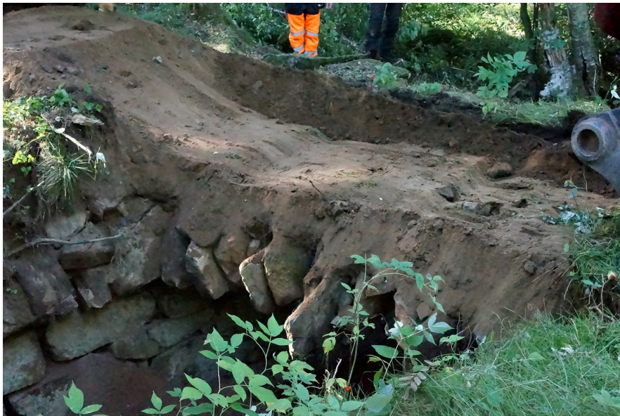
Figur 8–9. Bilderna visar när grus- och sandfyllningen ovanpå valvet tas bort med grävmaskin.
