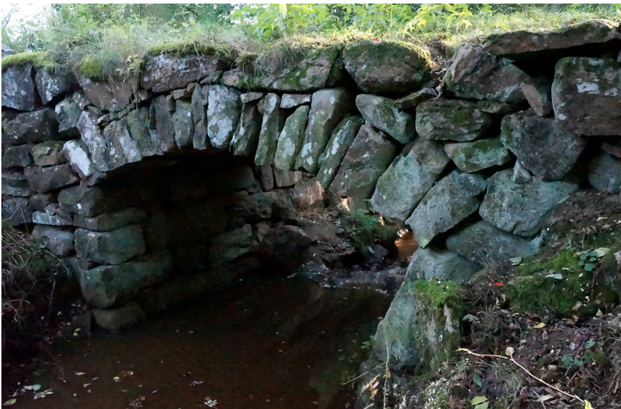
Figur 3–4. Brons intakta västra sida före rivning.
