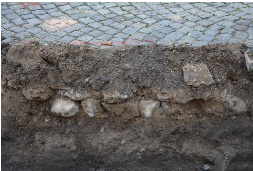
Figur 3. Under torgets gatsten framkom en kullerstensbeläggning
