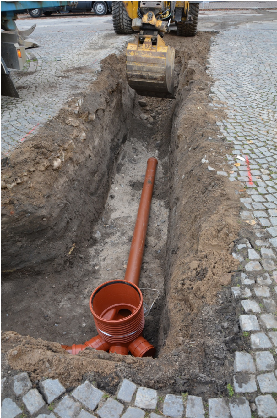
Figur 5. Bilden visar den del av schaktet som låg inne på Drottningtorget. Det ljusa i botten på schaktet är det naturliga underlaget
